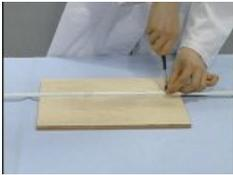
3 モールの端から45cmの位置に板の端にあわせ、モールと木に穴をあけ、ネジで留めます。
